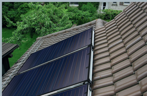
Montaggio applicato sul tetto
